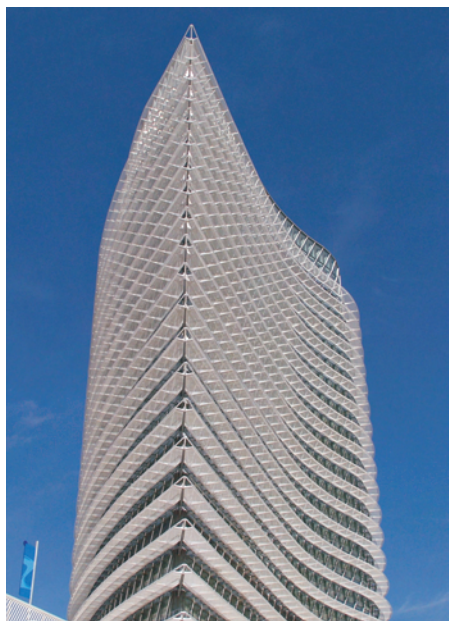
Zaragoza, Torre del Agua
